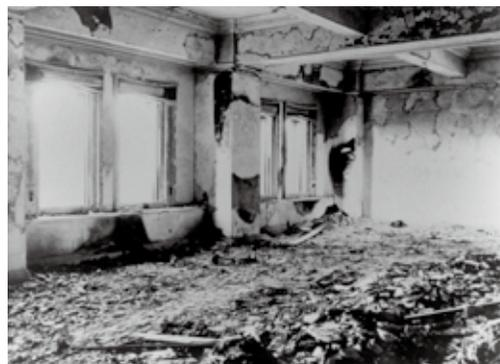
3階の窓が開いていたため、被害のひどかった3階の室内（米国返還資料より）
