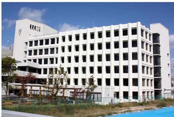
工事完了後の南面の様子
