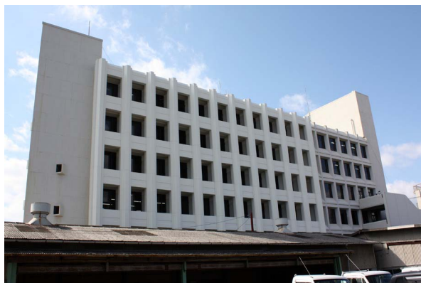
工事完了後の北面の様子
